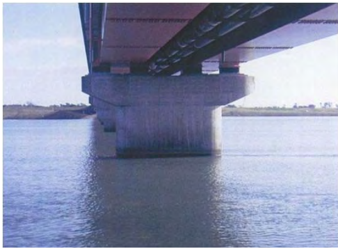
巨理大橋 巨理町荒浜地内 耐震補強工事
