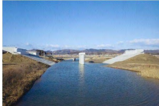
相馬巨理線 平成29年3月 橋梁下部工完成
