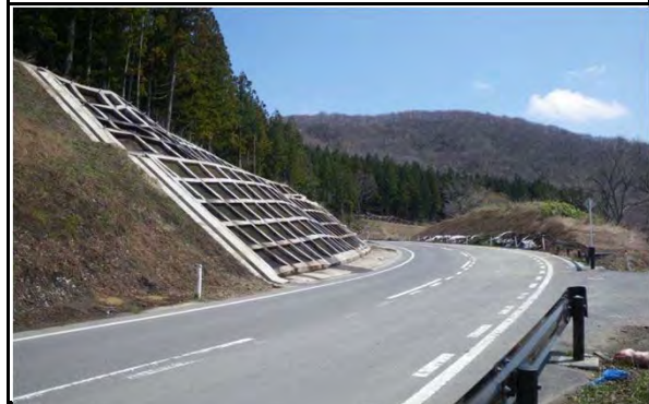
平成28年12月 現在 完成
