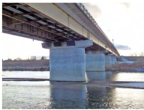
平成28年11月 完成 落橋防止装置・変位制限装置・橋脚巻立て
