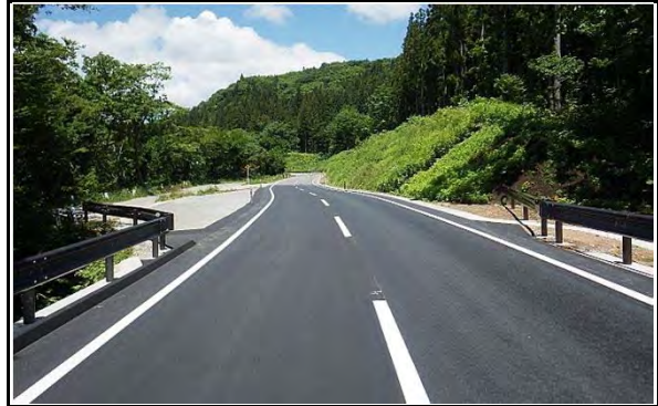
平成28年11月 現在 完成
