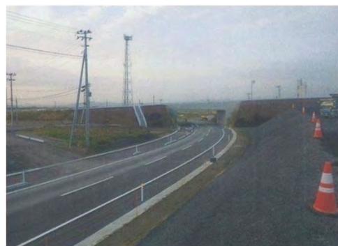
荒浜港今泉線 平成28年11月 ボックス部完成
