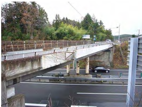
(主) 仙台村田線 村田町菅生地内 支承補強工事
