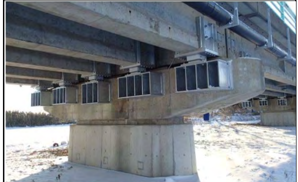
平成29年2月 現在 沓座拡幅, 支承補強 完成
