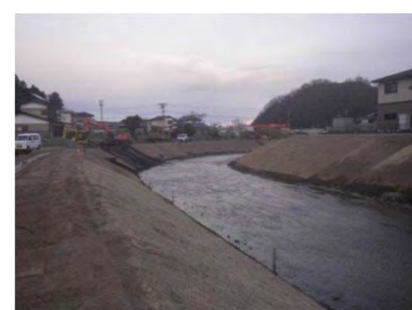
平成29年3月 完了
