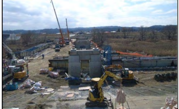
平成29年3月 現在 撤去 施工中
