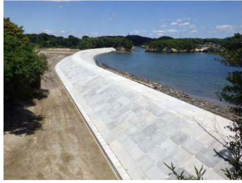
平成28年6月 現在 本復旧 完成
