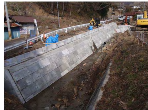
平成29年3月 施工中
