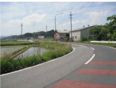
(主) 中田栗駒線 栗原市栗駒岩ヶ崎下町裏地内 岩ヶ崎道路改良事業
