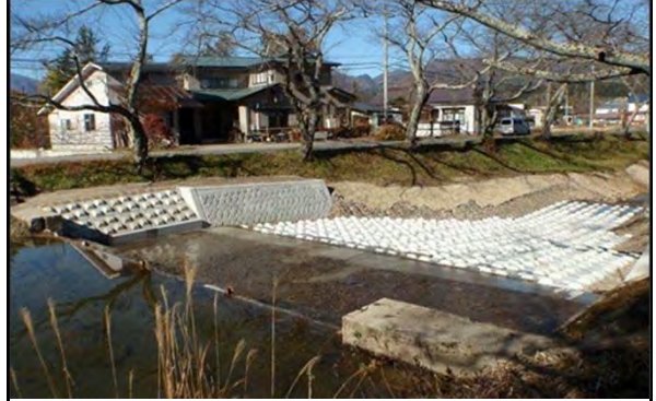
平成29年3月 現在 本復旧 完成
