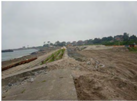
葛蒲田地区海岸 七ヶ浜町葛蒲田浜地内 海岸堤防復旧工事
