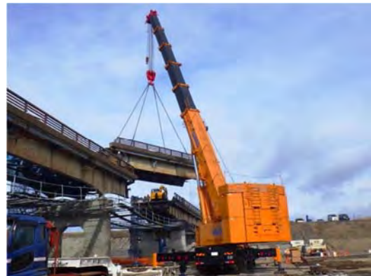
撤去が進む旧志田橋
