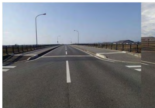
平成28年11月 完成 高欄・伸縮装置・橋面舗装
