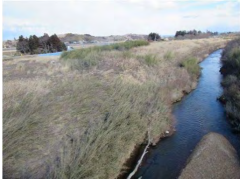
二迫川 栗原市築館富上境内 二迫川外河道掘削工事
