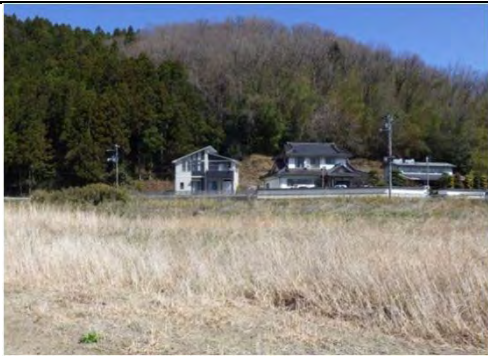
雉子尾川 丸森町大内地内 排水樋門工事 着手前
