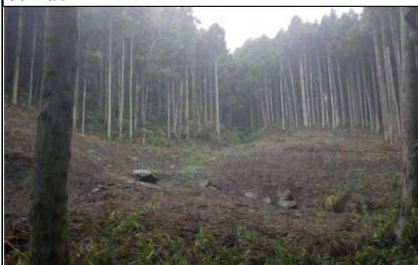
川畑沢 涌谷町猪岡短台地内 砂防堰堤工事着手前
