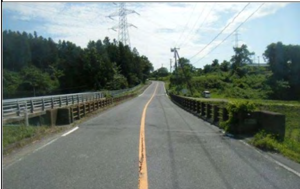
南澤橋 国道457号 大崎市岩出山 地内 耐震補強前
