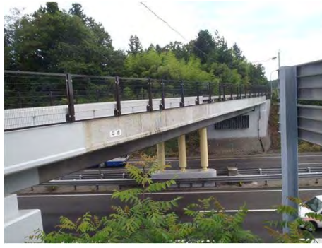
平成28年8月 完了
