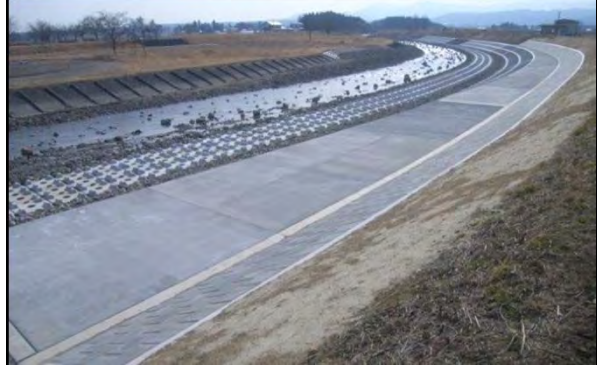
平成29年3月 現在 本復旧 完成
