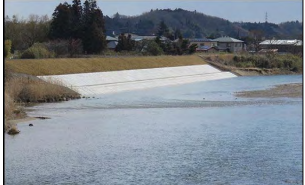
平成29年3月 現在 本復旧 完成
