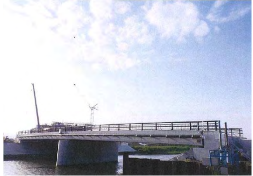
平成28年8月 現在 本復旧 架設完了
