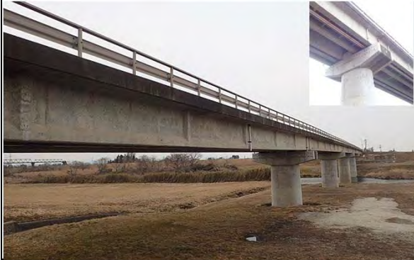
高倉橋 坂本古川線 大崎市三本木齊田地内 着手前
