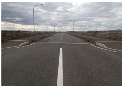
一般県道若柳花泉線 栗原市若柳地内 若柳第二大橋耐震補強工事
