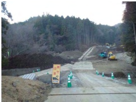
(主) 岩沼蔵王線 (岩沼市志賀地内) トンネル坑口起点
