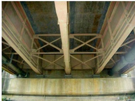
(一) 大河原高倉線 大河原地内 耐震補強工事(緩衝チェーン設置)・塗替塗装前
