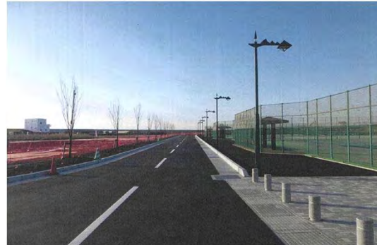
平成29年3月 現在 完成
