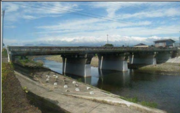
国道457号 色麻町籠檀地内 花川橋耐震補強着手前
