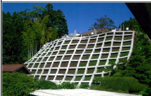
平成28年7月 現在 工事 完成
