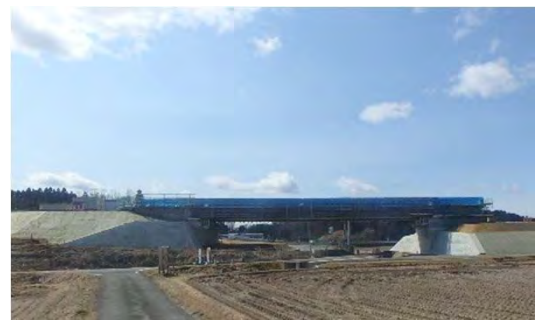
平成29年3月 下部工完了 上部工施工中
