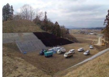
平成29年2月 施工中
