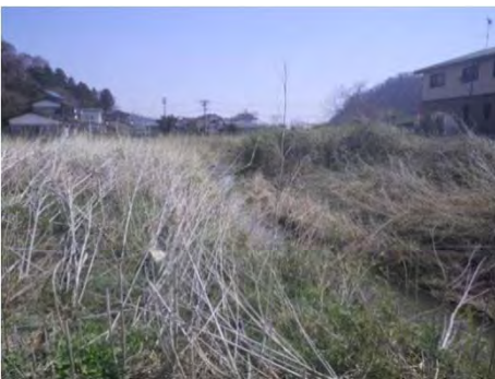
平家川 蔵王町 宮地内 河道掘削工事着手前
