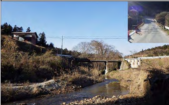
白子田橋 県道岩出山宮崎線 加美町下多田川地内 耐震補強(架換)
