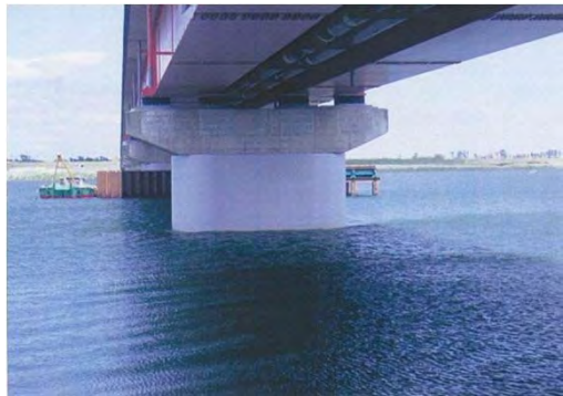
巨理大橋 巨理町荒浜地内 平成28年7月 P3巻立工完成
