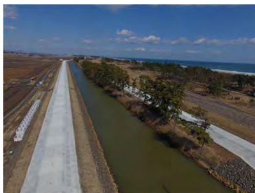
五間堀川河川災害復旧工事
