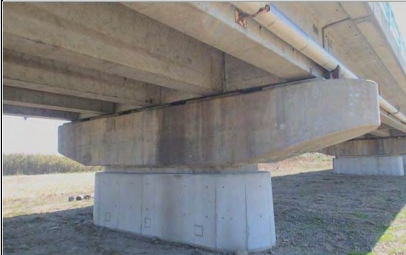
旭橋 小野田三本木線 加美町月崎地内 着手前
