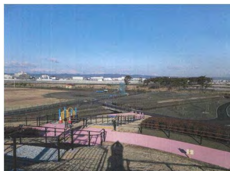
平成29年3月 現在 完成
