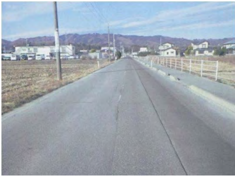
山下停車場線 山元町山寺地内 避難路整備
