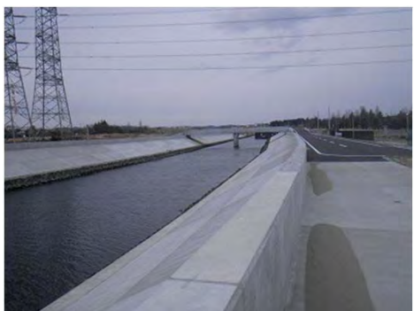
平成28年12月 現在 本復旧 完成
