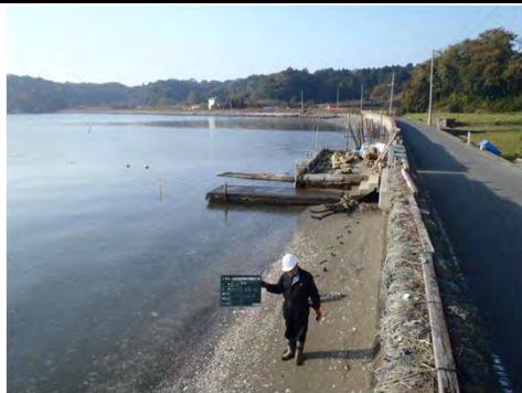
小白浜地区海岸 松島町手樽地内 海岸堤防復旧工事
