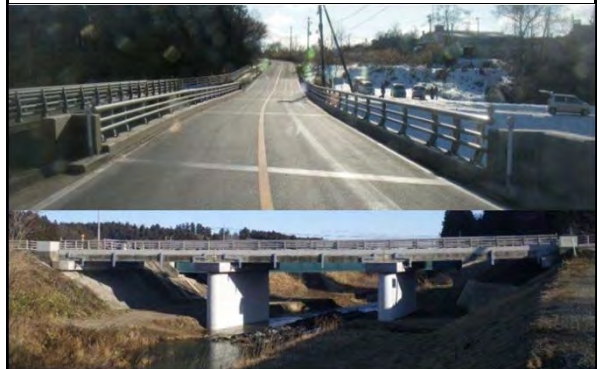
平成29年3月 現在 耐震補強工事 完成
