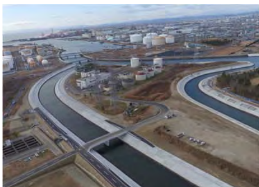
砂押川河川災害復旧事業
