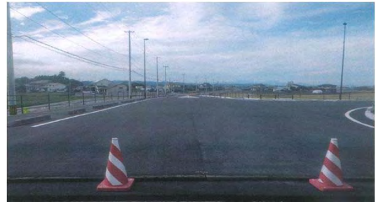
平成29年3月 現在 完成
