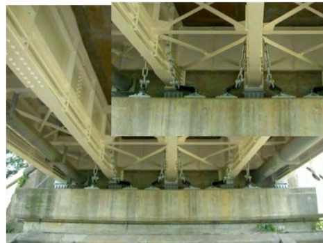
平成28年9月 完了
