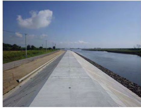
平成28年8月 現在 本復旧 完成
