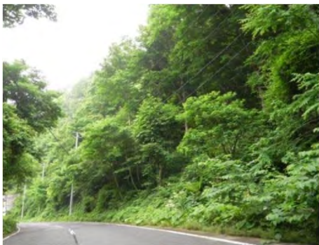
(主) 築館栗駒公園線 栗原市栗駒沼倉西沼ヶ森地内 西沼ヶ森災害防除工事
