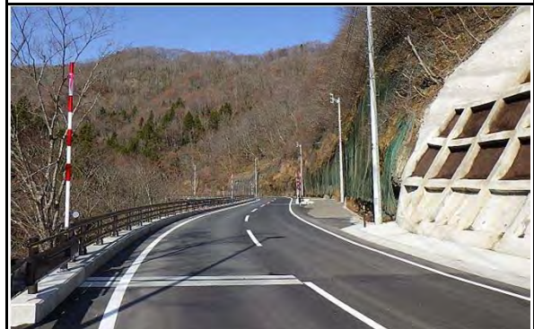
平成28年11月 現在 完成
