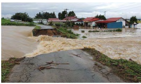
二迫川 栗原市築館黒瀬 二迫川河川災害復旧工事
