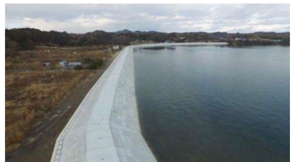
平成28年12月 現在 本復旧 完成
