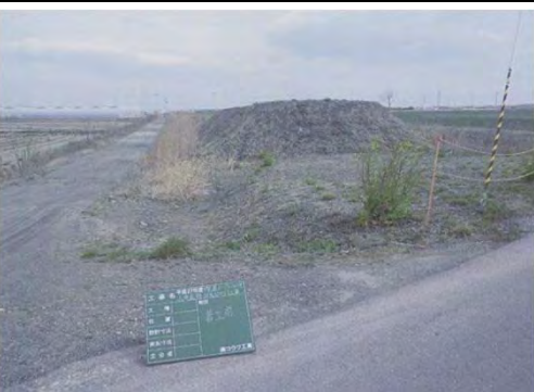
相馬巨理線 山元町山寺地内 避難路整備
