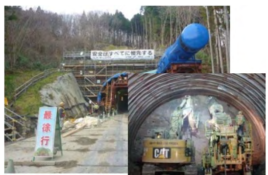
平成29年2月 施工中
