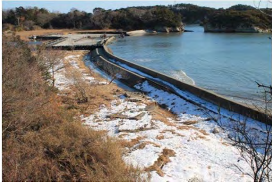
野々島地先海岸 塩竈市浦野々島地内 海岸堤防復旧工事
