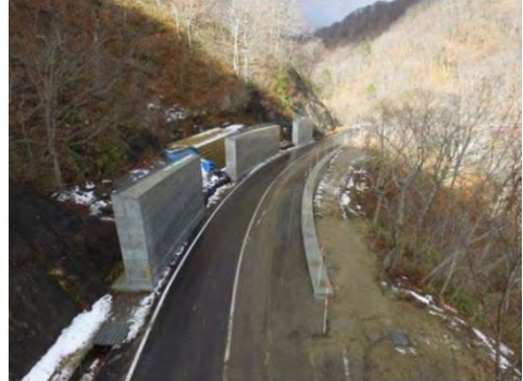
平成28年度分完成状況 谷側下部工
