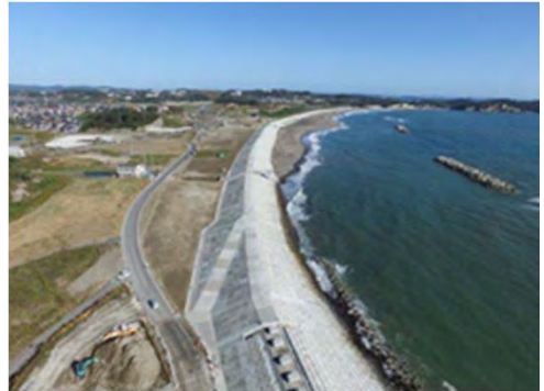
平成28年12月 現在 本復旧 完成
