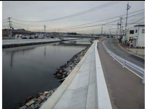
平成28年6月 現在 本復旧 完成
