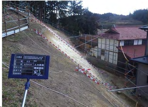
平成29年年3月 Aブロック 掘削完了
