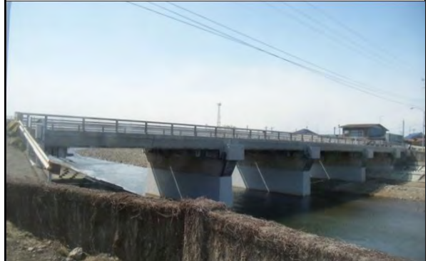
平成28年12月 現在 完成
