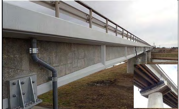
平成29年2月 現在 耐震補強工事 完成
