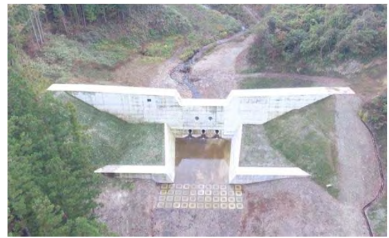
平成28年10月 現在 本復旧 完成
