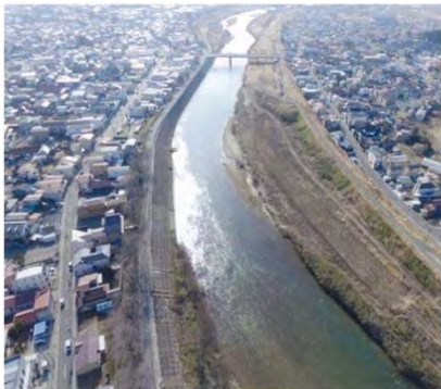
迫川 栗原市若柳字川南南町地内 迫川河道掘削工事
