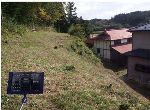
有賀沢 栗原市栗駒桜田蛇壇地内 有賀沢急傾斜地崩壊対策工事
