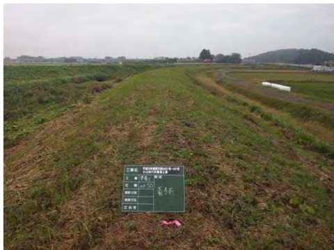
小山田川 栗原市瀬峰蔵王境内内 小山田川外築堤工事
