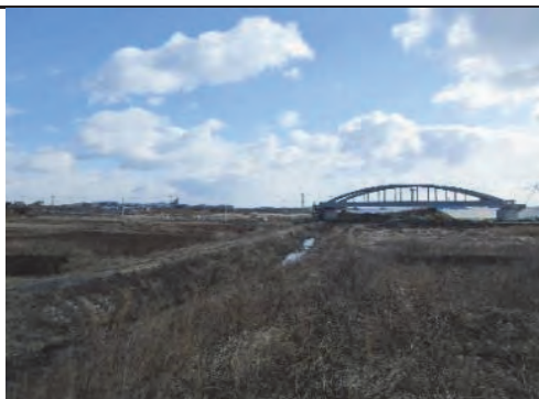
⑨ 沖ノ田川 気仙沼市本吉町野々下地内外 沖ノ田川災害復旧工事
