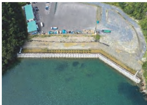
⑧ 荻浜港海岸(有田浜地区) 石巻市荻浜地内 荻浜港有田浜地区防潮堤（その2）外工事
