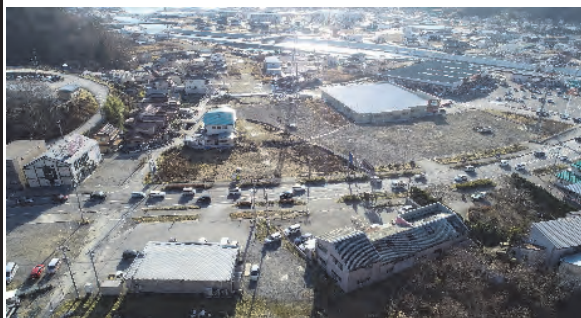
⑧ (一)大島浪板線 気仙沼市東八幡前地内 復興道路整備事業 (R45号付近)
