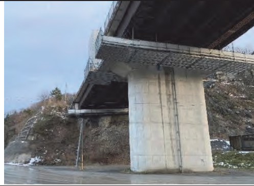
① 令和3年3月 施工中
