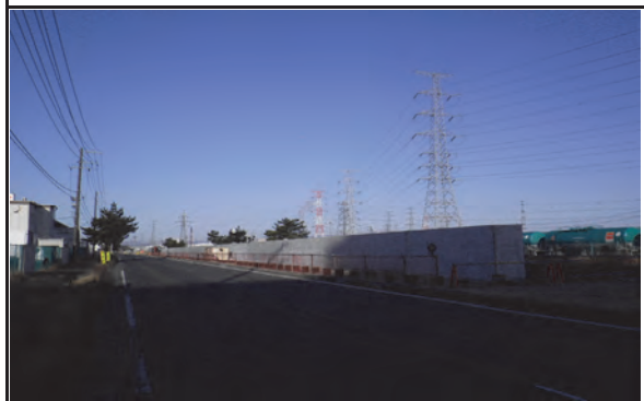
⑪ 令和3年3月 施工中
