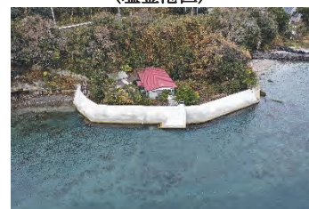
石浜護岸 (塩釜港区)
