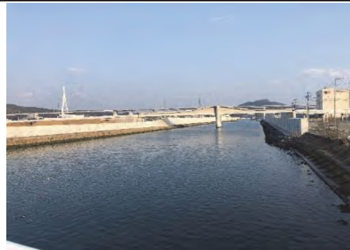
④ 令和3年3月 施工中
