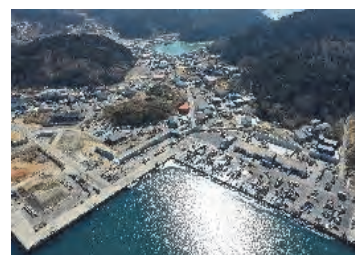
施工中：表浜港
