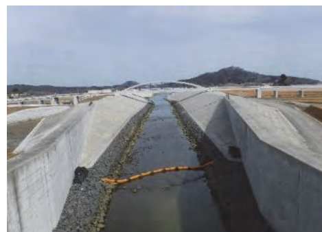
⑤ 令和3年3月 施工中
