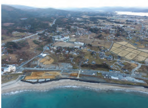
⑩ 大谷地区海岸 気仙沼市本吉町三島地内 大谷地区海岸防潮堤工事
