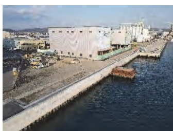
完成：石巻港区日和地区工事
