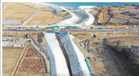
⑨ 令和3年3月 施工中
