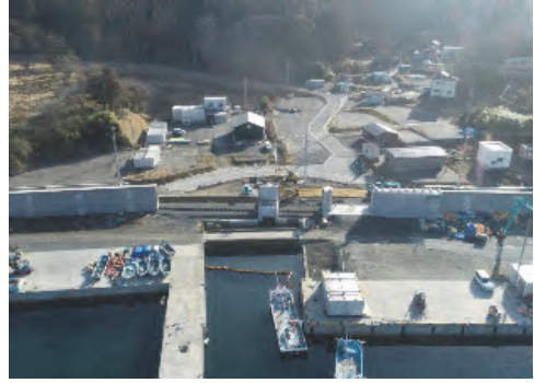
⑨ 令和3年3月 現在 施工中
