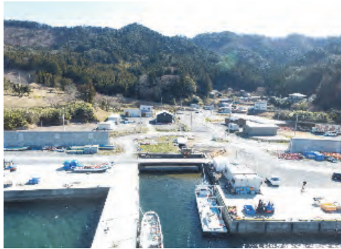
⑨ 雄勝港海岸(大浜地区) 石巻市雄勝町大浜地先外 大浜防潮堤外災害復旧(その4) 工事
