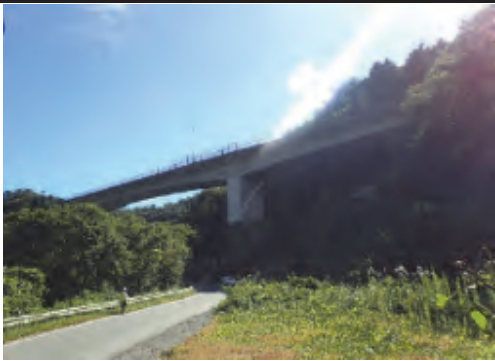
② (国) 284号 気仙沼市下八瀬地内 山びこ大橋橋梁耐震補強工事
