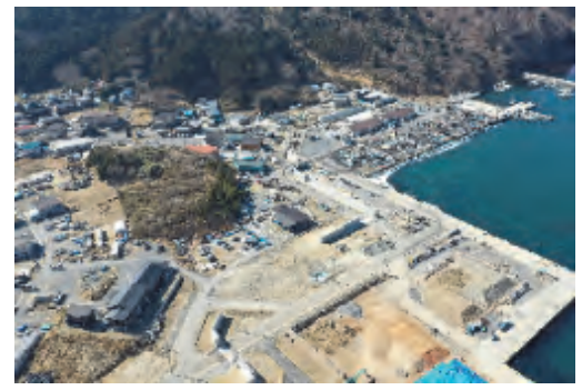
⑪ 令和3年3月 現在 施工中
