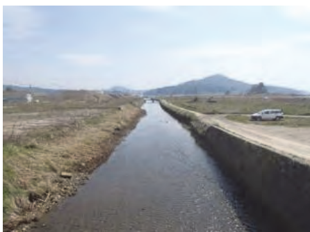
⑤ 面瀬川 気仙沼市松崎馬場地内外 面瀬川河川災害復旧工事
