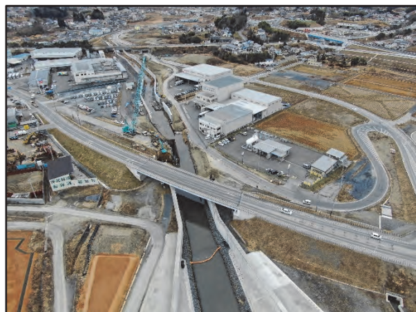
(主)気仙沼唐桑線 新面瀬橋 （令和2年6月 完成）
