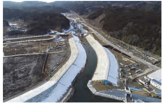
③ 令和3年3月 施工中
