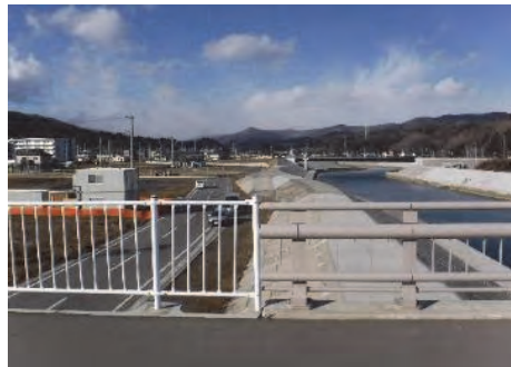
③ 令和3年3月 施工中
