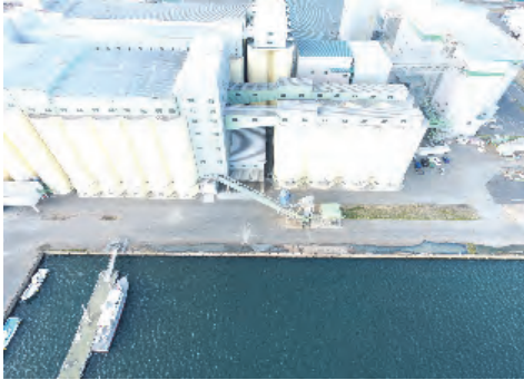
③ 仙台塩釜港石巻港区海岸日和地区 石巻市三河町地内外 日和地区外防潮堤工事
