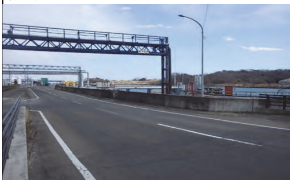
④ 仙台塩釜港（塩釜港区）塩竈市貞山通二丁目地内 貞山通（A）胸壁外災害復旧外工事（その3）
