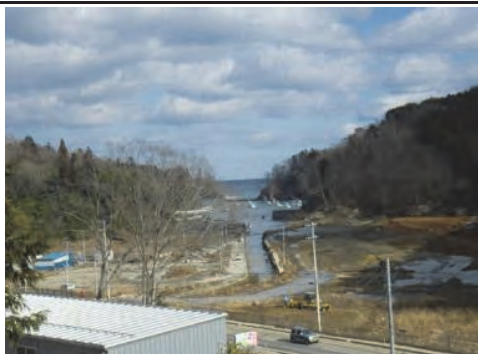
② 港川 南三陸町歌津字港地内 港川河川災害復旧工事
