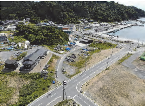
⑪ 表浜港海岸 石巻市給分浜地内 表浜防潮堤(その1) 工事
