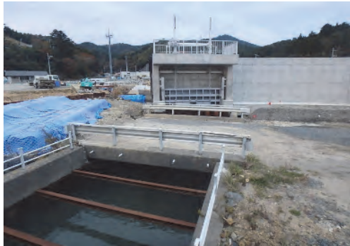
⑦ 荻浜港海岸(荻浜地区) 石巻市荻浜地内 桂川橋梁外災害復旧工事
