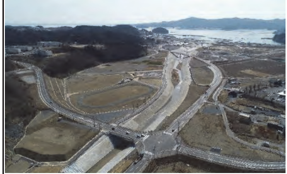
④ 令和3年3月 施工中
