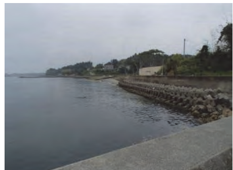
⑧ 千岩田地区海岸 気仙沼市岩月千岩田地内 千岩田地先海岸災害復旧工事
