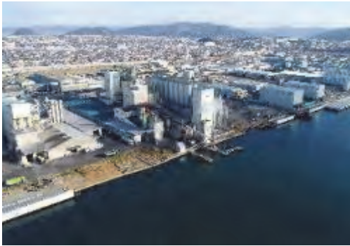
④ 仙台塩釜港石巻港区海岸日和地区 石巻市三河町地内外 日和地区防潮堤（その2）工事
