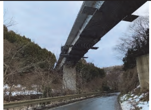
② 令和3年3月 施工中
