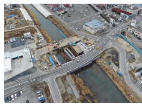
⑦ 令和3年3月 下部工施工中
