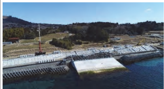
⑦ 令和3年3月 施工中
