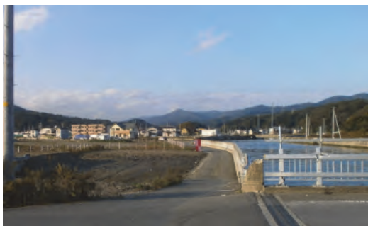
③ 鹿折川 気仙沼市浪板地内 鹿折川河川災害復旧工事
