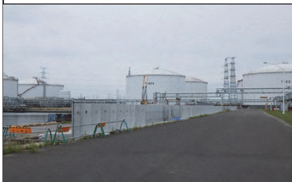
⑩ 令和3年3月 施工中
