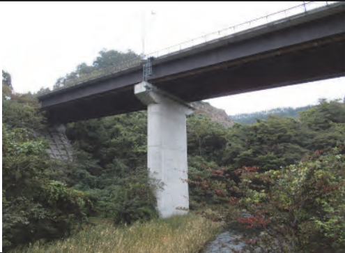
① (国) 284号 気仙沼市切通地内 猿岩橋橋梁耐震補強工事
