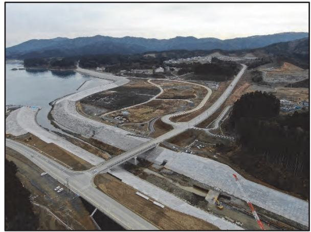
(国)398号 戸倉復興道路 (令和3年1月 完成)
