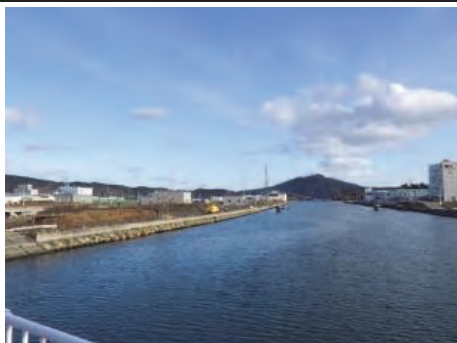
④ 大川 気仙沼市赤岩港地内外 大川外河川災害復旧工事
