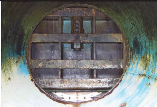
② 栗駒ダム 栗原市栗駒沼倉玉山 地内 栗駒ダムジェットフローゲート修繕工事 着手前
