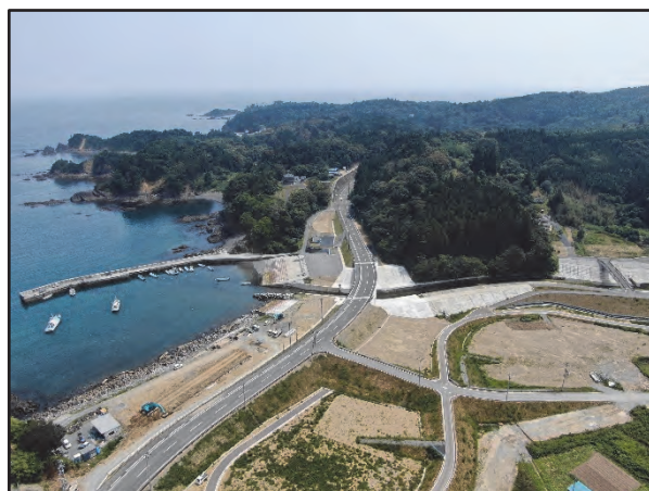
(国)398号 長清水道路・橋梁 （令和2年7月 完成）
