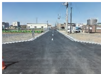
完成：石巻港区北1号線災害復旧
