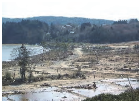
④ (一)大島浪板線 気仙沼市田中浜地内 道路災害復旧事業 (田中浜)
