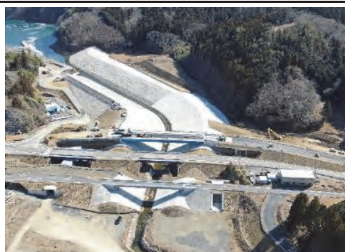
② 令和3年3月 施工中
