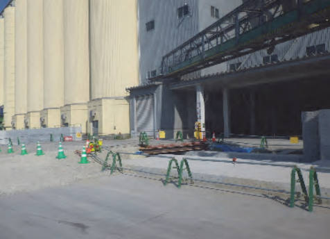
⑤ 仙台塩釜港石巻港区 石巻市三河町地内外 石巻港区防潮堤陸閘（その4）工事
