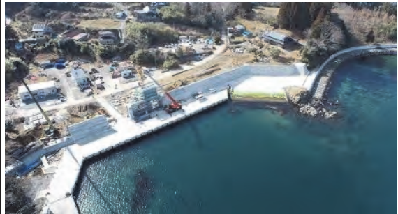
⑥ 令和3年3月 施工中
