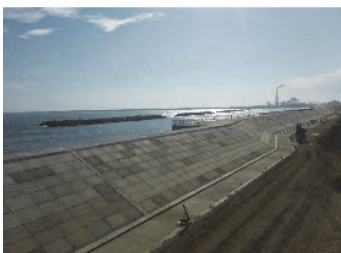
完成：石巻港区東浜防潮堤災害復旧
