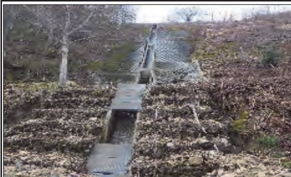
③ 漆沢ダム 加美町字漆沢宮ヶ森地内 災害復旧事業／法面災害復旧工
