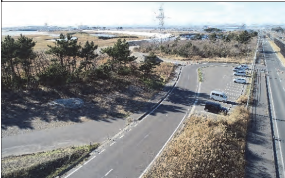
① 仙台塩釜港（仙台港区）仙台市宮城野区中野地内 向洋地区防潮堤工事（その3）
