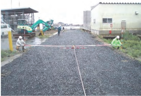
① 仙台塩釜港石巻港区 石巻市三河町地内 臨港道路北1号線外災害復旧工事
