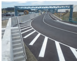
貞山通(A)胸壁 (塩釜港区)
