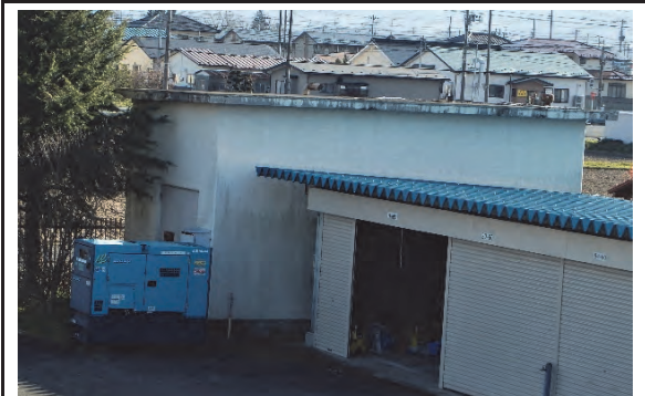
④ 大崎地方ダム総合事務所 加美町城生字前田地内 堰堤改良事業／非常用電源設備改良工事
