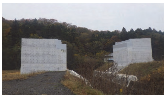
② 川内沢ダム 名取市愛島笠島地内 ダム建設事業／付替市道2号橋上部工工事
