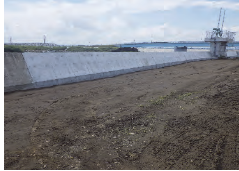
⑥ 令和3年3月 現在 施工中
