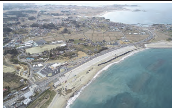
⑩ 令和3年3月 施工中
