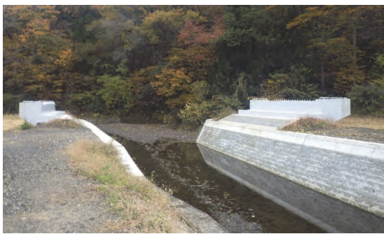
① 川内沢ダム 名取市愛島笠島地内 ダム建設事業／付替市道1号橋上部工工事
