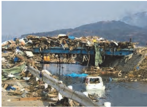
⑥ (主)気仙沼唐桑線 気仙沼市松崎方浜地内 道路・橋梁災害復旧事業 (面瀬橋)
