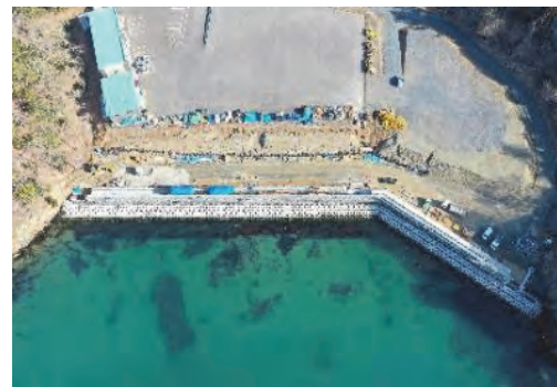
⑧ 令和3年3月 現在 施工中
