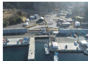
施工中：雄勝港大浜立浜災害復旧
