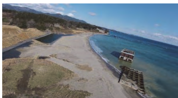
⑪ 中島地区海岸 気仙沼市本吉町中島地内 中島地区海岸災害復旧工事
