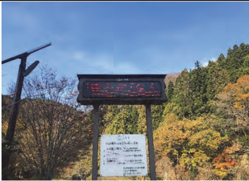
① 花山ダム 栗原市一迫字滝口 地内 花山ダム警報表示板改良工事 着手前
