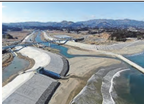
⑫ 令和2年3月 施工中
