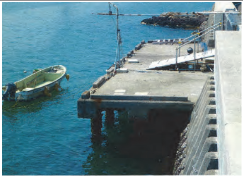
② 気仙沼港（小々汐地区） 気仙沼市小々汐地先 小々汐物揚場災害復旧工事
