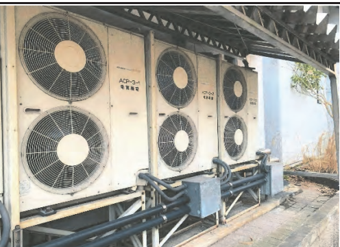
⑤ 宮床ダム 黒川郡大和町宮床字笹倉地内 堰堤改良事業／空調設備改良工事
