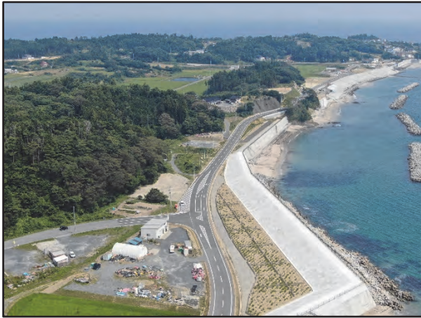
(一)泊崎半島線 泊崎復興道路 (令和2年6月 完成)
