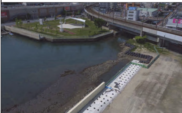
⑨ 仙台塩釜港（塩釜港区） 塩竈市海岸通地内外 海岸通水門外工事
