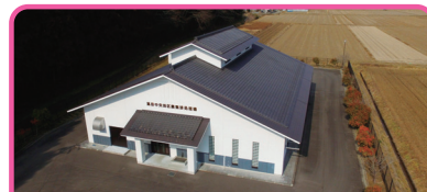
農業集落排水施設整備事業 簗岳中央地区
