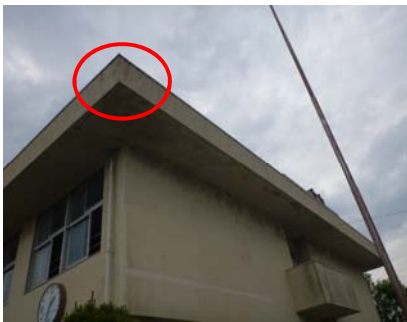
庇の南東角部分。
