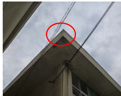
庇の南東角部分。
