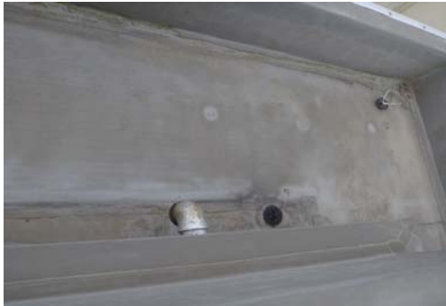
庇部分のシート防水
