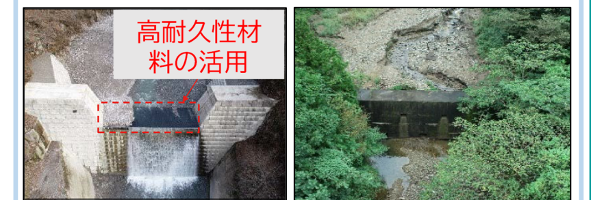
写真1 ヴァ-スチ-ルによる天端摩耗の補修
