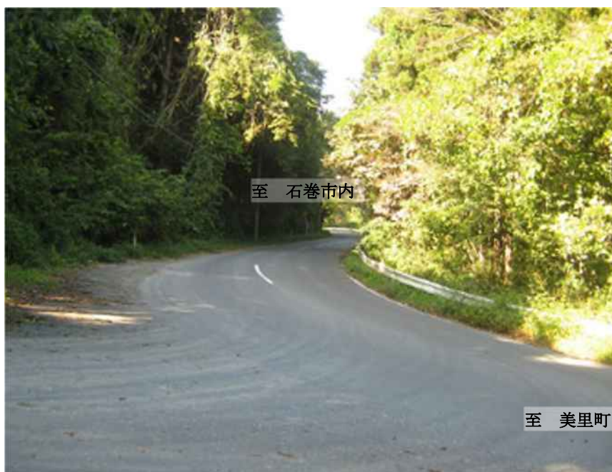
線形不良箇所
