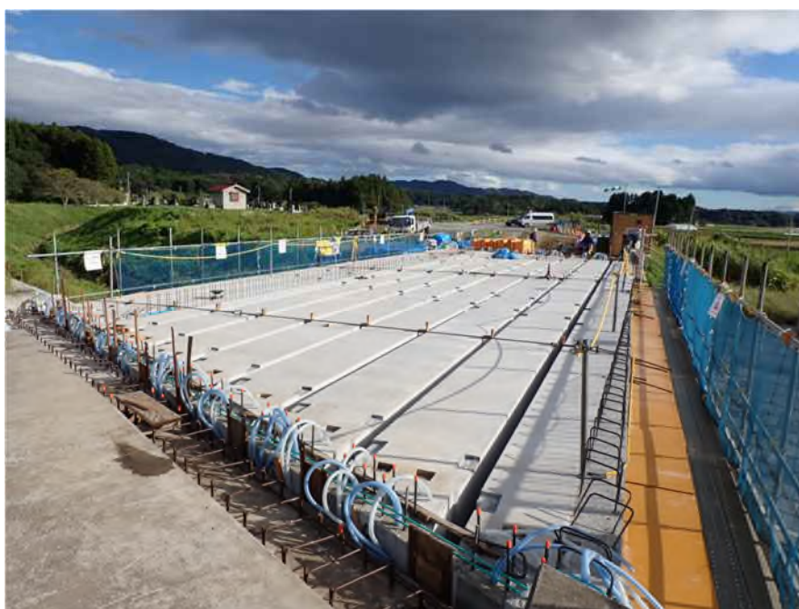
諏訪橋 施工状況
