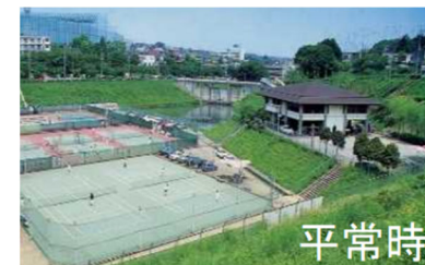
校庭貯留、ため池、調整池
