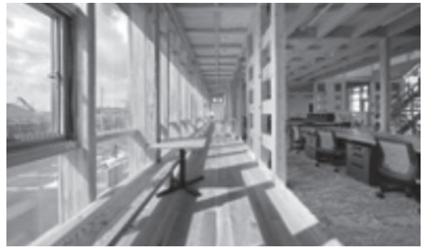
▲CLTを活用した木造社屋
