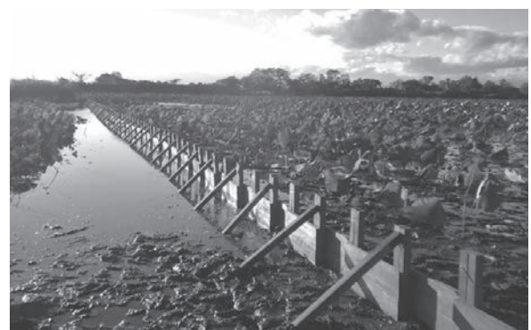
▲エコトーン造成作業の様子
