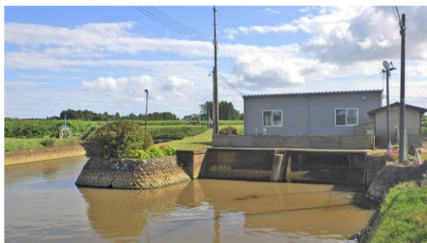
▲ 現在の上区排水機場
