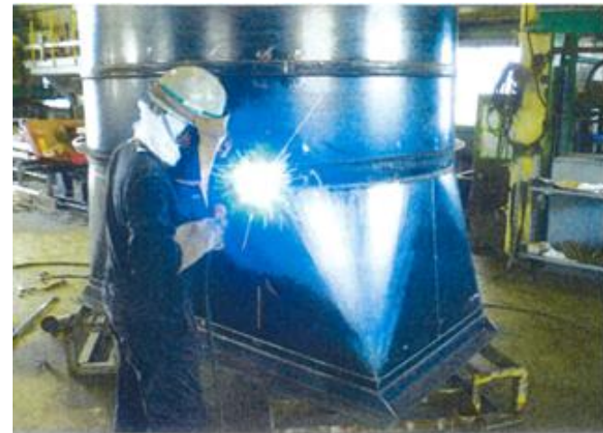
原子力関連設備の溶接作業。
