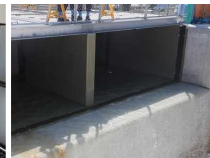
海洋放出開始時 (下流水槽へ越流)
