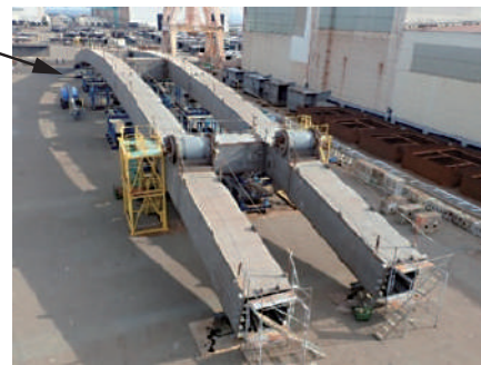
アーチ部仮組立
