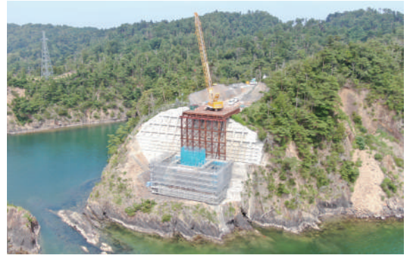
出島側:P2橋脚、A2橋台
