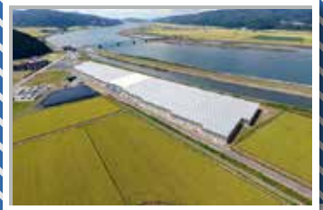
復興事業が完了した大川地区と 大規模園芸施設(石巻市)
