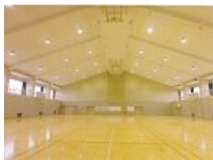
講堂天井改修（完成）
