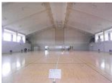
講堂天井改修（着手前）
