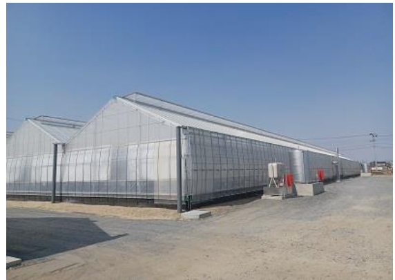
いちごの大型鉄骨ハウスの整備を支援
