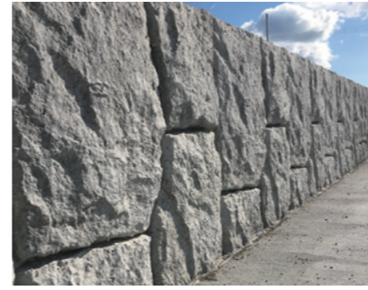
浜田漁港、海側の防潮堤。
