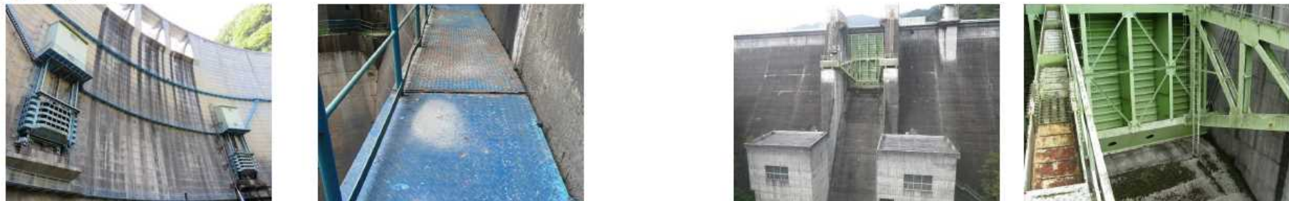
ダム管理用通路の改修(塗装)
