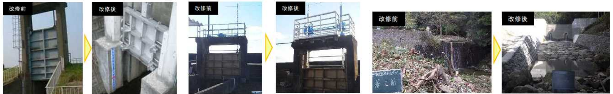
河川・海岸における老朽化した施設(水門等)の改修
