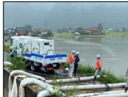
排水施設の整備
