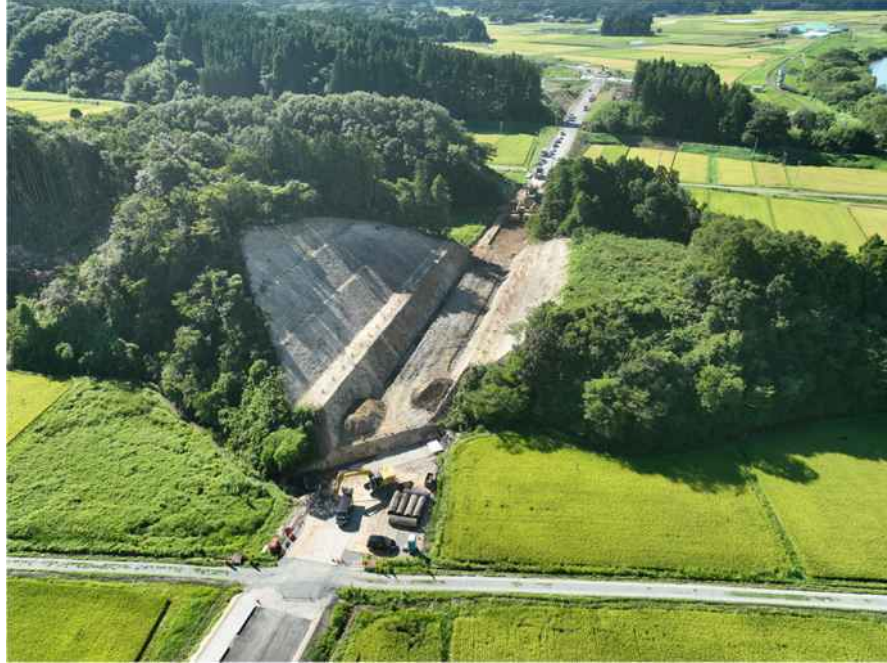
道路改良工 施工状況
