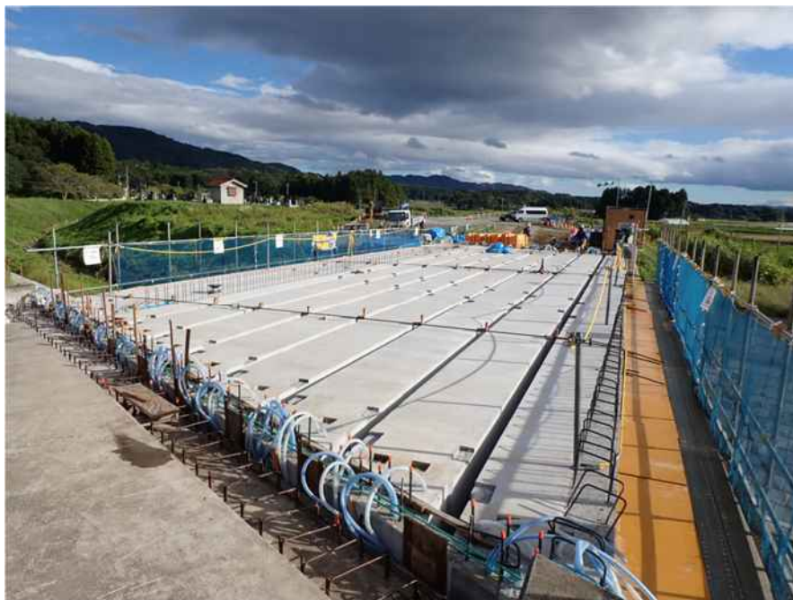
諏訪橋 施工状況
