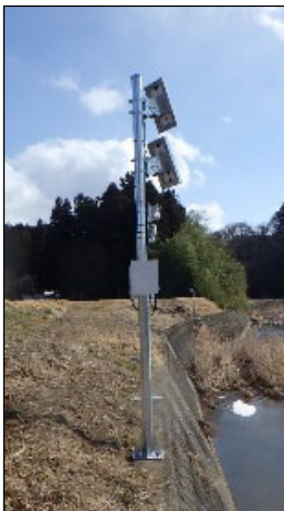
監視カメラ 設置状況（七北田川）
