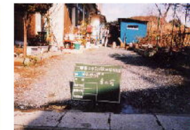
■ ボックス貯留（コンクリート）
