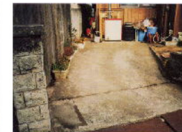
■ 空隙貯留（石油化学製品）
