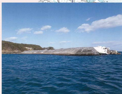
【完成した離岸堤】
