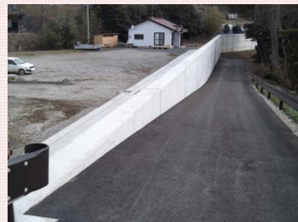
【完成した防潮堤(下の浜地区)】
