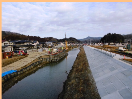
鹿折川(気仙沼市東みなと町地内)
