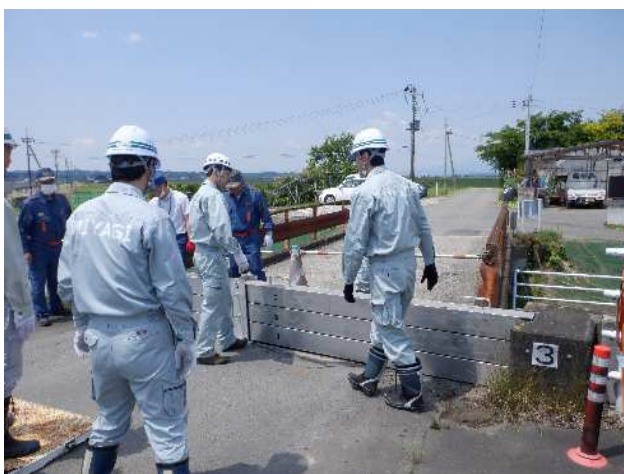
【角落とし陸閘の閉鎖手順確認状況】
