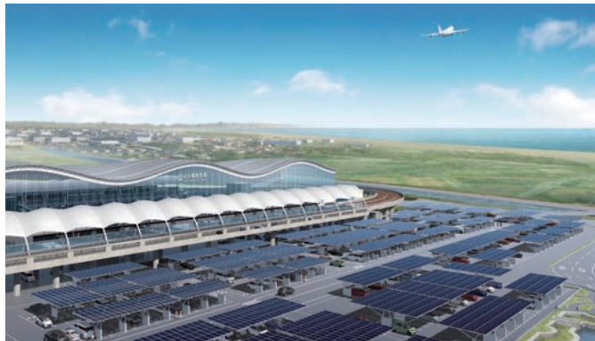
第一駐車場に設置されるソーラーカーポート (イメージ)
