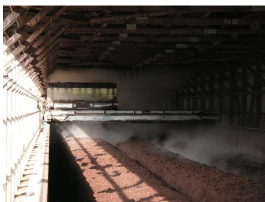
堆肥センター
