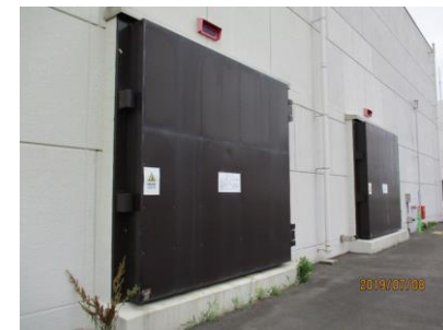
浸水防止壁の設置(仙塩・自家発) 浸水防止施設の設置(仙塩・ポンプ棟シャッター・階段) 耐水扉の設置(県南)
