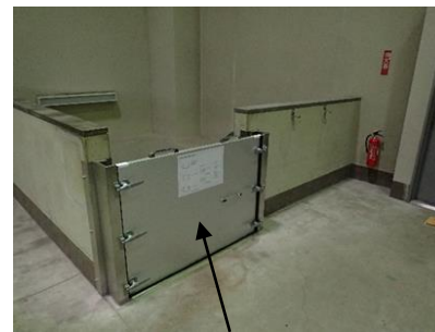
浸水防止壁の設置(仙塩・自家発) 浸水防止施設の設置(仙塩・ポンプ棟シャッター・階段) 耐水扉の設置(県南)
