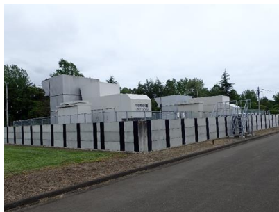
浸水防止壁の設置(仙塩・自家発) 浸水防止施設の設置(仙塩・ポンプ棟シャッター・階段) 耐水扉の設置(県南)
