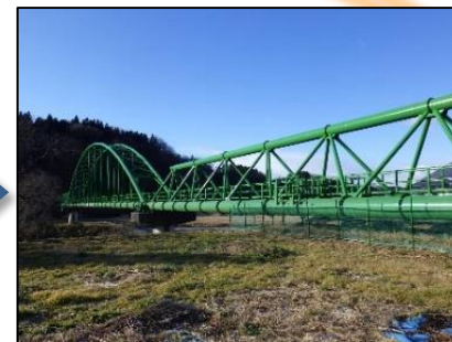
水管橋(送水管)
