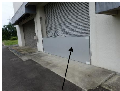
浸水防止壁の設置(仙塩・自家発) 浸水防止施設の設置(仙塩・ポンプ棟シャッター・階段) 耐水扉の設置(県南)
