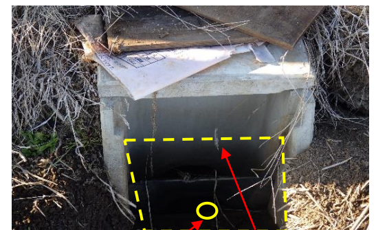
※排水口（φ4cm） ※雨水貯留調整板
