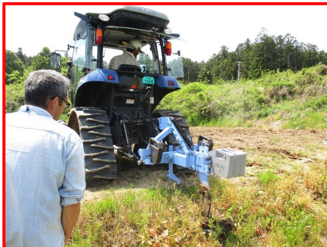
排水対策 （カットドレーン） 1.5m間隔×深さ 45～50cm
