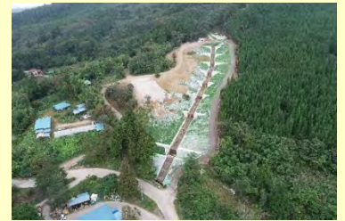
治山事業による復旧状況(山腹工)
