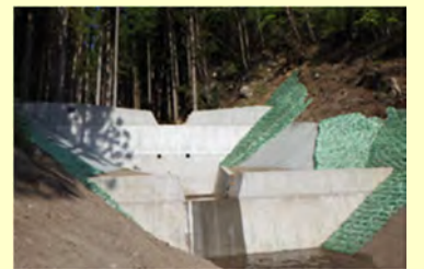
治山事業による復旧状況(治山ダム工)
