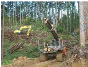
一貫作業現場の状況
