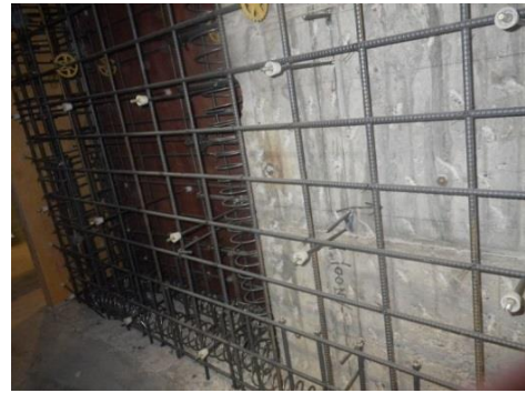
改修工事の施工状況
