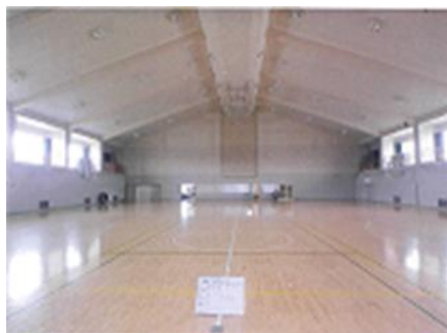
講堂天井改修（着手前）
