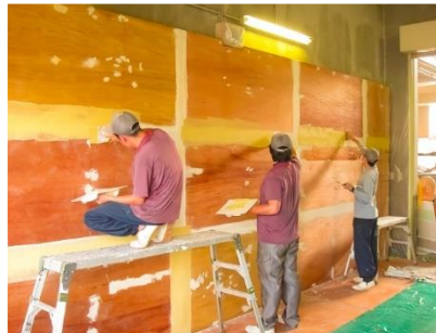
建築物塗装実習 (下地処理)
