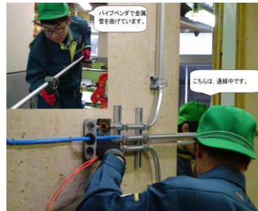
金属管工事実習
