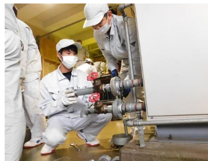
配管施工実習 (模擬家屋設備実習)
