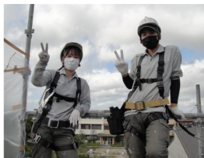
足場実習 (足場組立作業)
