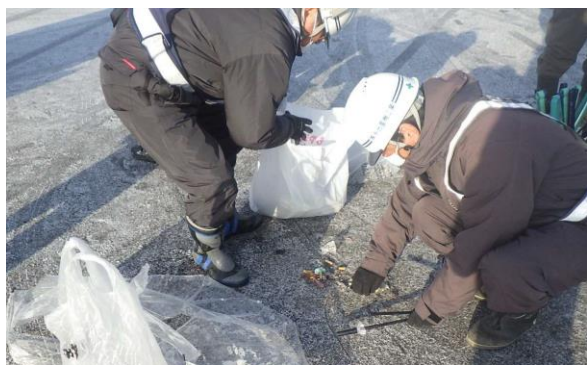
株式会社永光重機工業(12月17日) 国道398号(一迫) 清掃
