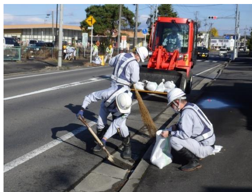
上田建設株式会社(11月4日) (一)若柳花泉線 除草・清掃
