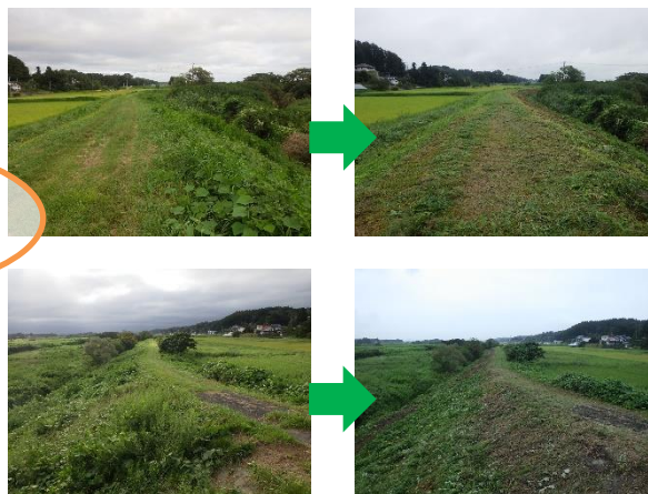
株式会社佐々貞土建(9月8日) 小山田川 富橋～樋管 左岸堤防 除草
