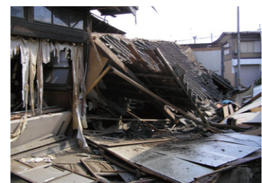
写真:倒壊した家屋(柴田町)
