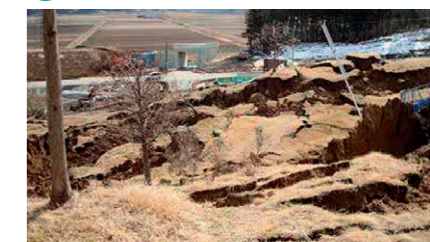
地震により、東和総合運動公園では、野球場やテニスコート場の法面崩壊が起きるなどの被害が発生しました。
