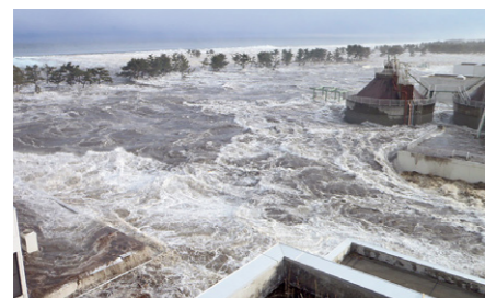
写真:岩沼市(県南浄化センターに押し寄せる津波)
