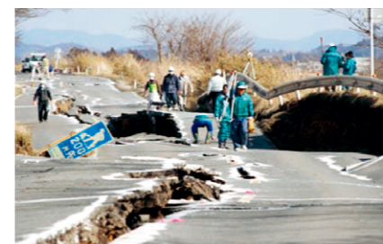
写真:栗原市(大きく波打った道路)
