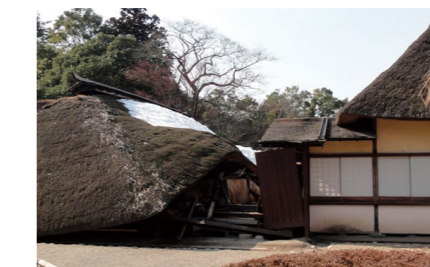
写真:大崎市(倒壊した旧有備館及び庭園)
