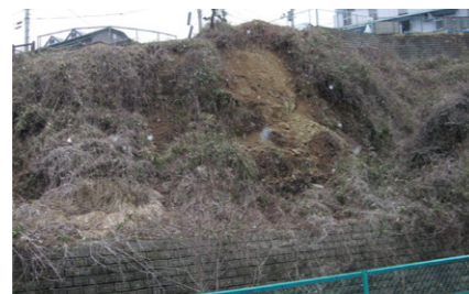
写真:仙台市(泉区のがけ崩れ)
