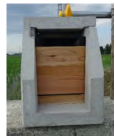
堰板 + 調整板設置
