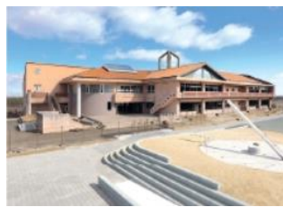
震災遺構中浜小学校 (山元町)
