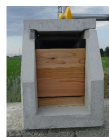
堰板+調整板設置
