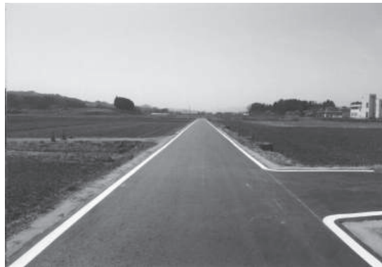
写真 復旧完了状況
