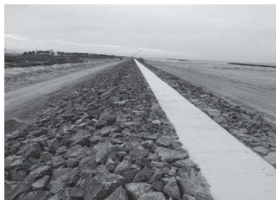
写真 国による応急仮堤防設置 (H23. 10)
