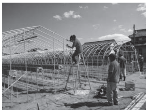
写真 パイプハウス建築作業(9/7 亘理町小山地区)
