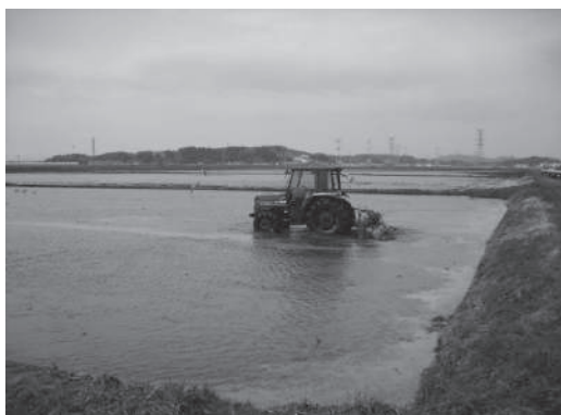
写真 除塩作業実施状況 (H23. 4)
