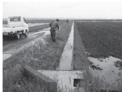
写真 復旧後の通水状況
