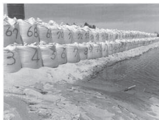
写真 農地海岸の応急復旧 (県施工 H23. 4)
