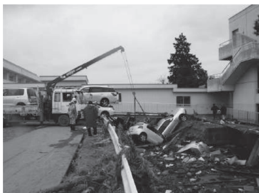
写真 災害廃棄物撤去作業状況
