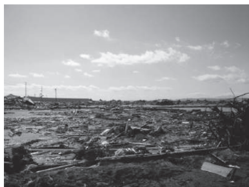
写真 農地の被災状況（仙台市）
