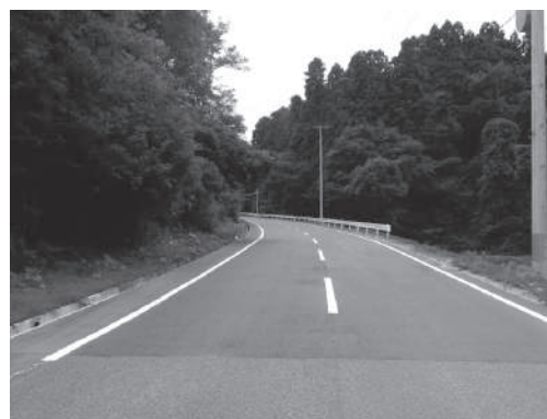
写真 復旧完了状況
