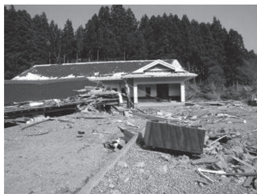
写真 農業集落排水処理施設の被災状況（気仙沼市）
