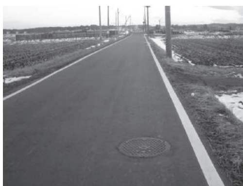
写真 復旧後の管路施設 (H24.12)
