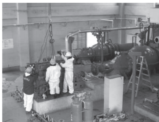
写真 機場の応急復旧作業状況
