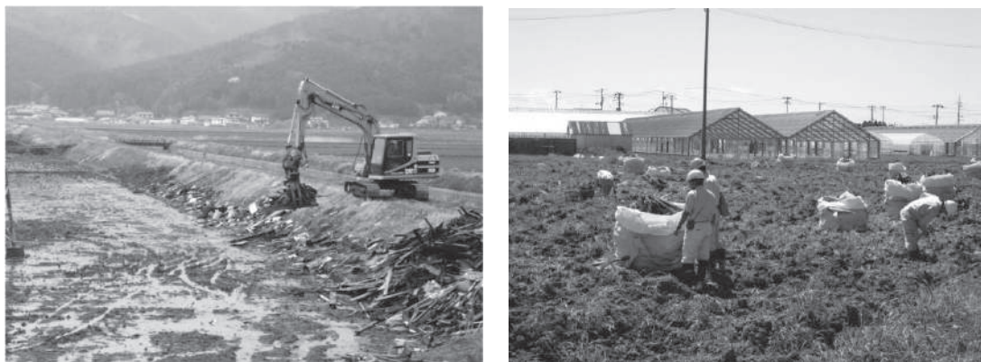
写真 農地の災害廃棄物撤去作業状況
