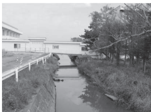
写真 災害廃棄物撤去後の排水路 (H23. 11)
