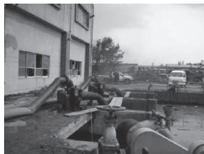
写真 応急ポンプによる湛水排除（名取市）
