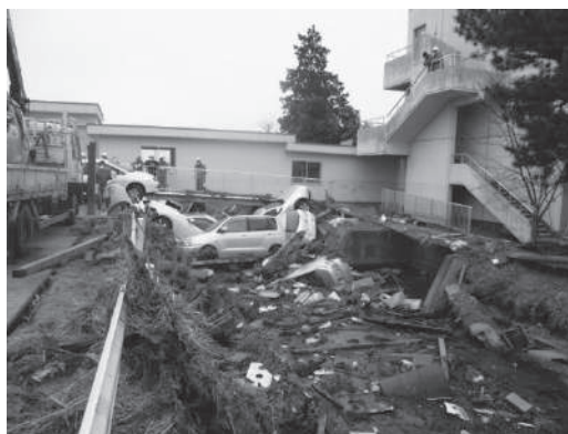
写真 被災直後の排水路 (H23. 3)
