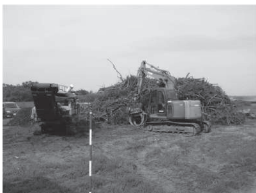
写真 耕作放棄地の整地作業(8/9 亘理町小山地区)
