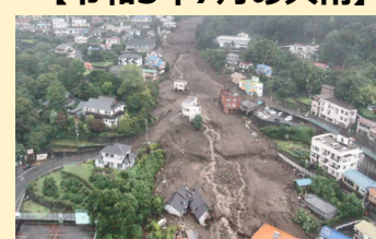
⑪土砂災害の状況 (静岡県熱海市)
