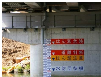
橋脚への水位表示例
