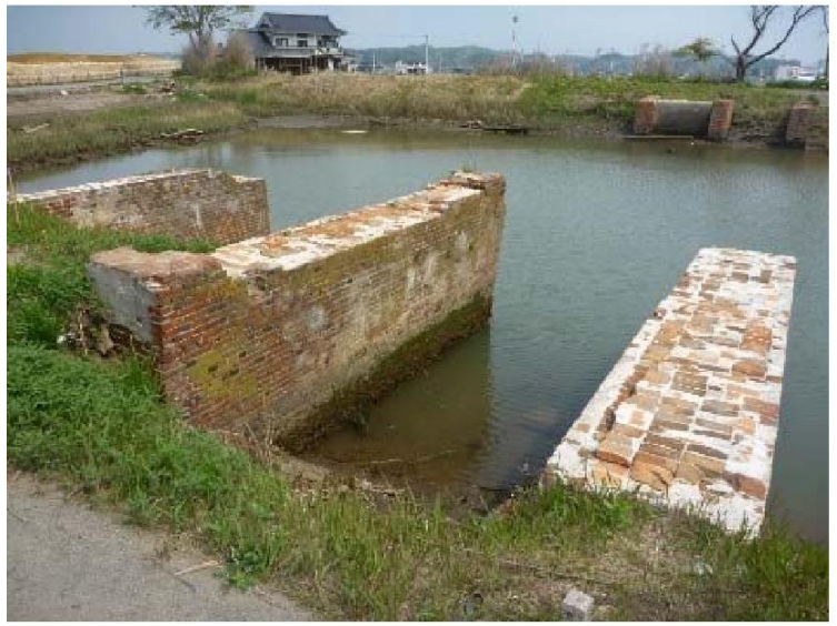
野蒜築港跡の煉瓦橋脚跡
