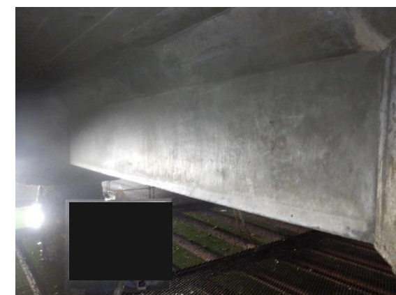
補修完了（断面修復工） 貞山 3号栈橋
