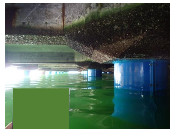
補修完了（杭被覆防食工） 貞山 4号栈橋
