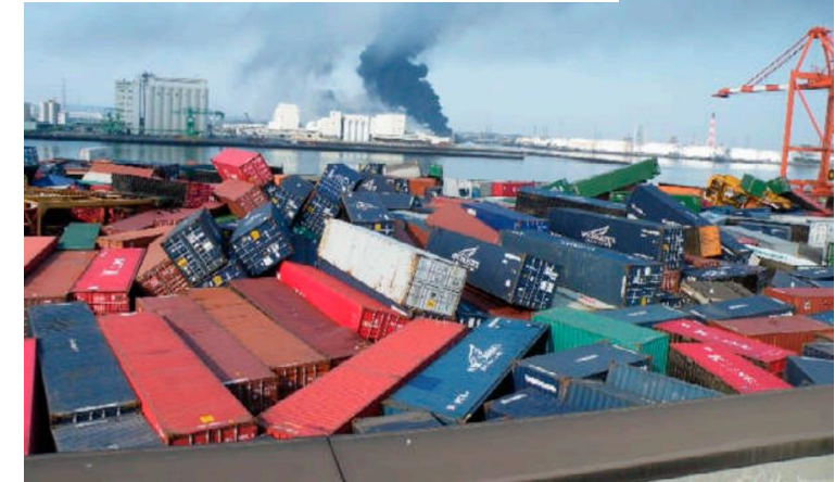
東日本大震災時の高砂コンテナターミナル散乱するコンテナ
