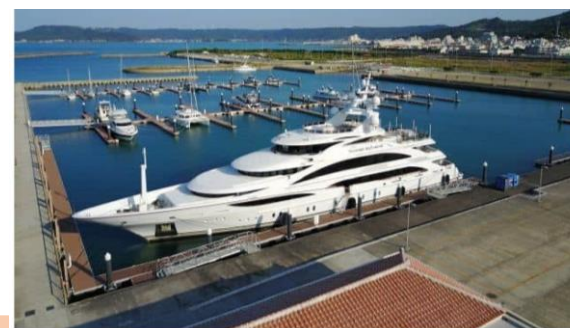
沖縄県与那原マリーナにおける受入拠点整備
