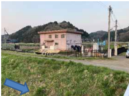
新舟渡排水機場 (村田町)
