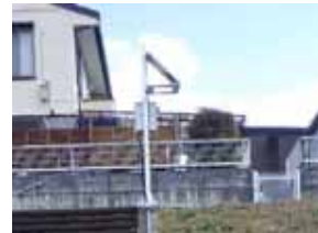
危機管理型水位計 (荒川・村田町)
