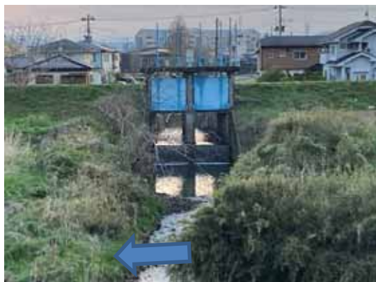
青木樋門 (大河原町)
