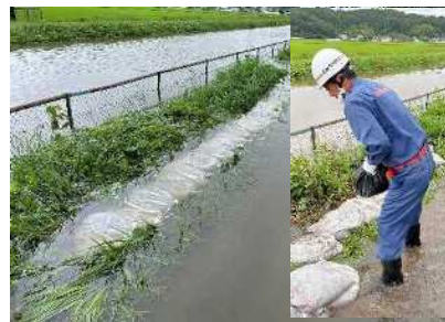
河南地区の浸水被害 (土のう積み)
