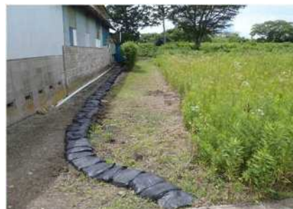
桃生地区の浸水被害 (土のう積み)
