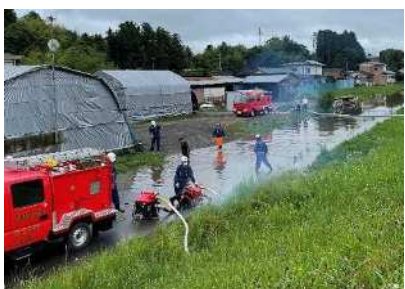
江合川右岸（元山谷地地先） 排水作業
