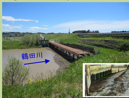
▲吉田川サイフォン入口 (鶴田川が右の吉田川の堤防の下を潜る)
