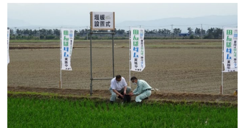
堰板設置式の様子
