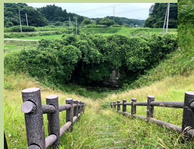
▲元禄潜穴ずり出し穴 掘削された土砂などを運び出した縦穴
