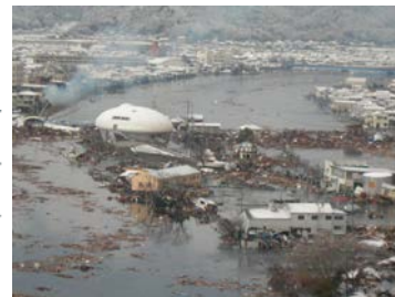
津波襲来後の様子（石巻市）
