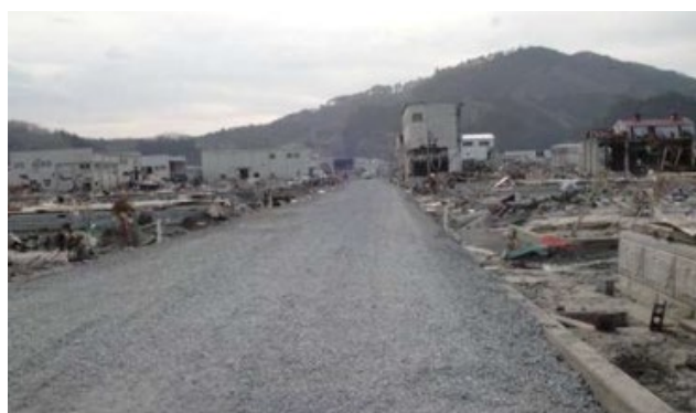
応急工事（道路）後の気仙沼市街地部（鹿折地区）
