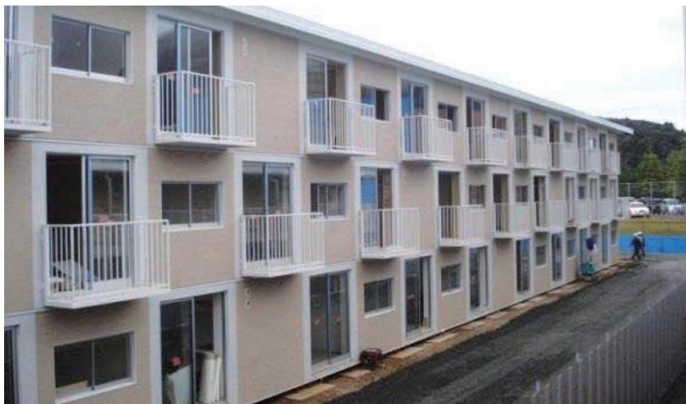
図 2-119 コンテナを利用した多層型応急仮設住宅 女川町運動公園野球場地区
