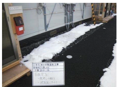
棟間舗装・凍結防止対策
