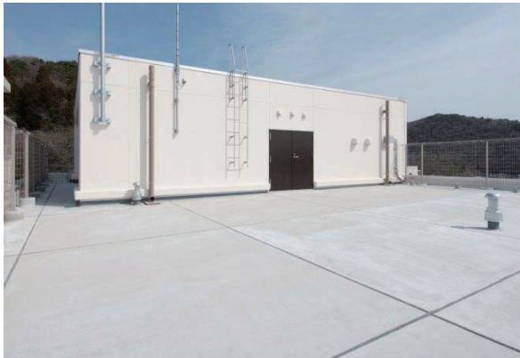
図 2-160 屋上へ一次避難スペースと隣接し，防災倉庫を設置
