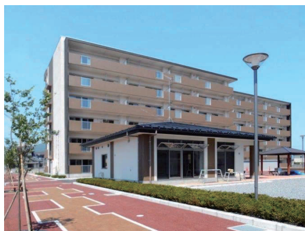
図 2-142 県受託（石巻市黄金浜北地区）
