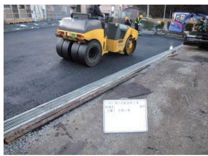
舗装・排水工事
