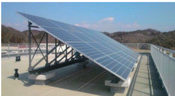
図 2-165 屋上へ太陽光発電設備を設置
