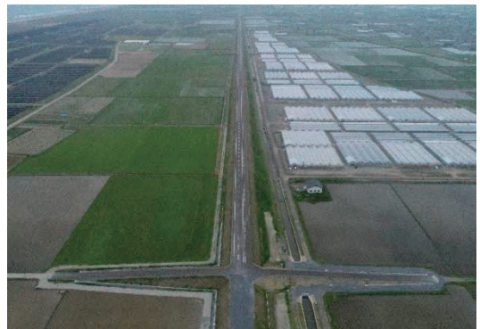
図 2-84 (町) 橋本堀沿線 平成 28 (2016) 年 2 月
