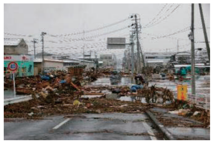
図 2-60 冠水により通行不能となった道路
